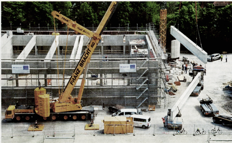
Spektakulär: Insgesamt zehn Stahlbeton-Binder mit einem Gewicht von jeweils 30 Tonnen sind an der neuen Sporthalle des Helmholtz-Gymnasiums mit einem Spezialkran in Position gebracht worden.
