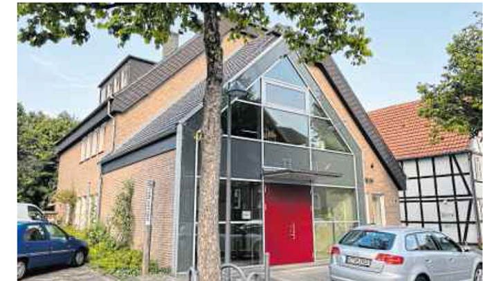
Das in den 1970er Jahren erbaute Pfarrheim soll abgerissen und gegen einen Neubau mit deutlich größerem Volumen ersetzt werden.
