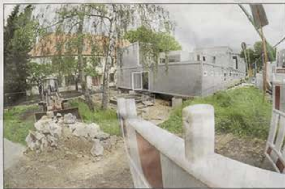
Seit Montag wird das Container-Gebäude vor dem Haupteingang der Schule aufgebaut.
