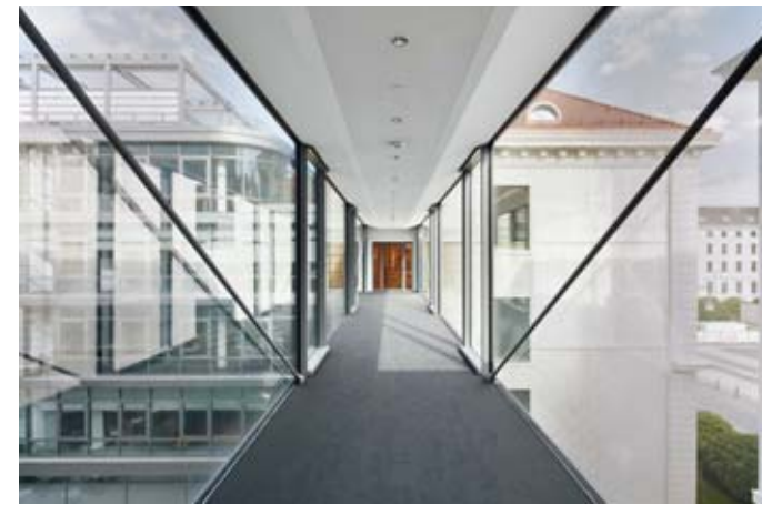
Die Glasbrücken sind die verbindenden Elemente von Alt zu Neu.
