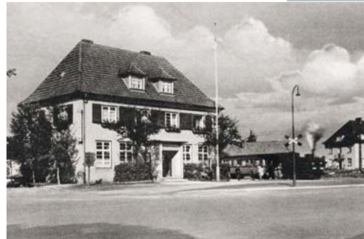
Ein altes Foto lieferte wertvolle Details für das Verständnis des Gebäudes.
