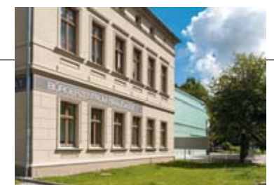
Auch farblich denkmalgerecht saniert.
