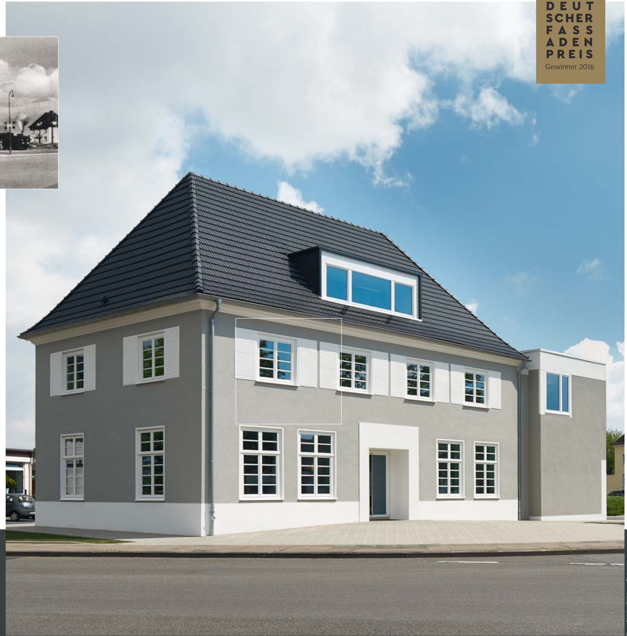
Die ursprünglich vorhandenen Fensterläden wurden in weiß abgesetzter Kammputz-Struktur neu abgebildet.
