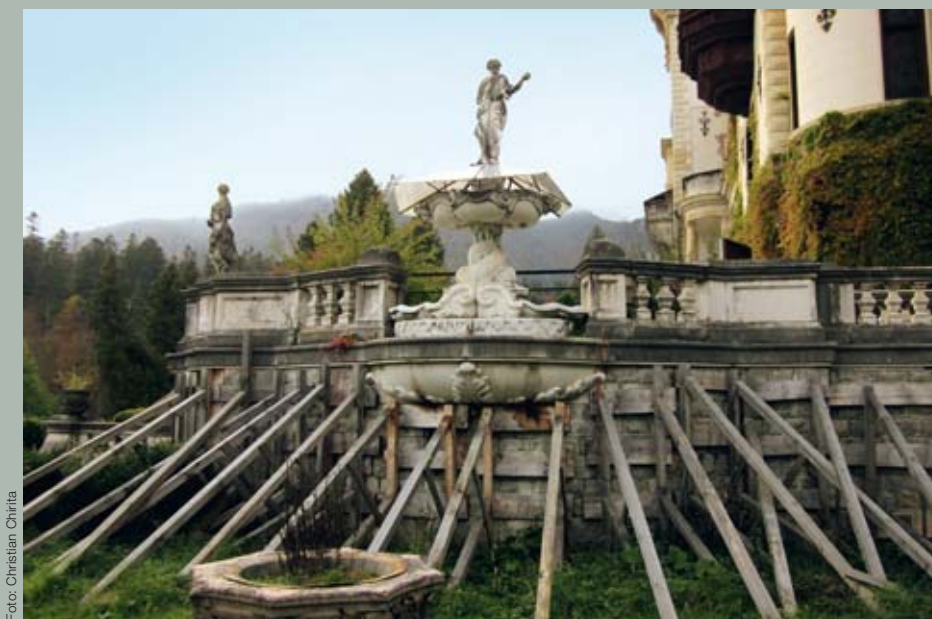
Die Front des rumänischen Schlosses Peles in den Karpaten – Stützen bewahren die Terrasse vor dem Einsturz.
