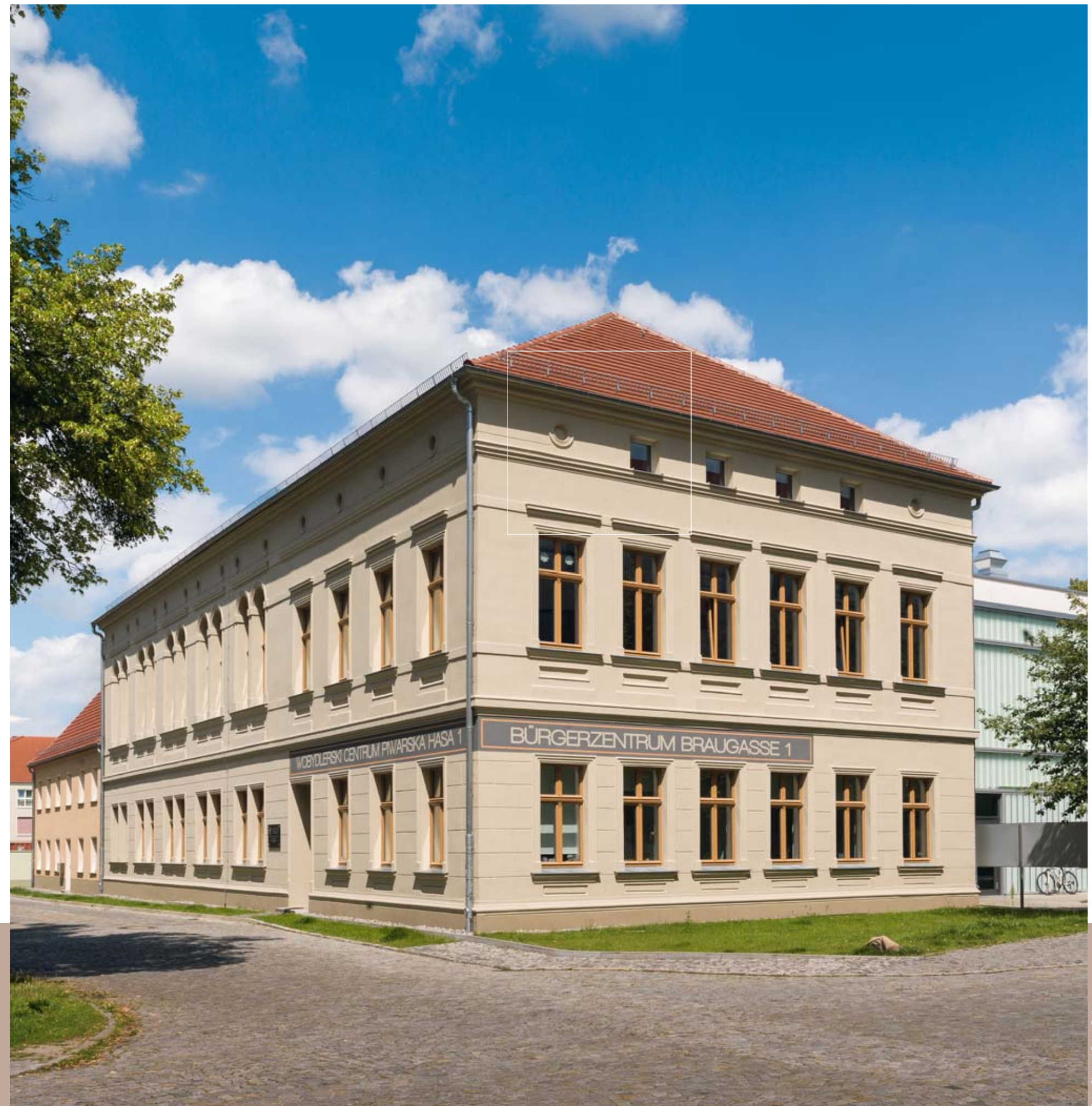
Eine denkmalgerechte Sanierung des historischen Ballhauses.
