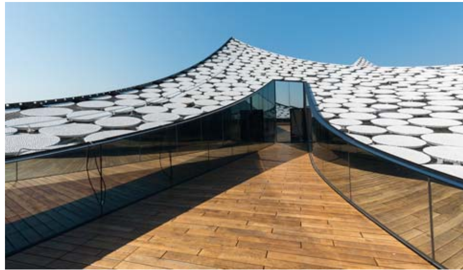
Mit 6.000 schimmernden Pailletten dekorierten Herzog & de Meuron die acht sphärisch gekrümmten Flächen, die dem Dach Schwung verleihen.
